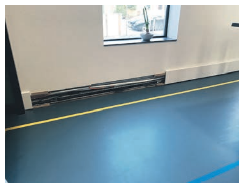
De wandgoot zorgt voor installatietechnische flexibiliteit in het gebouw.
