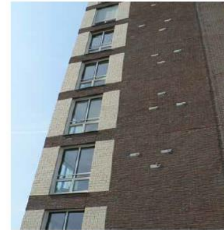
Meerdere neststenen in een gevel
