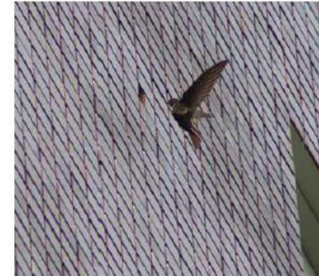
Gierwaluwsteen weggewerkt in gevel
