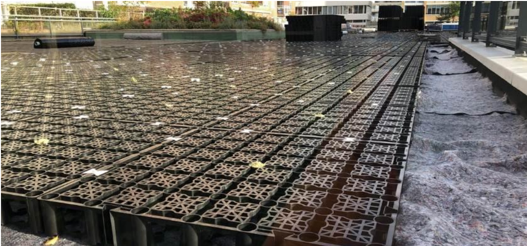
Figuur 11: Retentiekragen op het dak van een parkeergarage in Gravenlo (via ipcon.nl)
