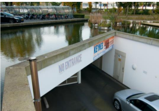
Figuur 12: Waterdak boven een parkeergarage (via rainproof.nl)
