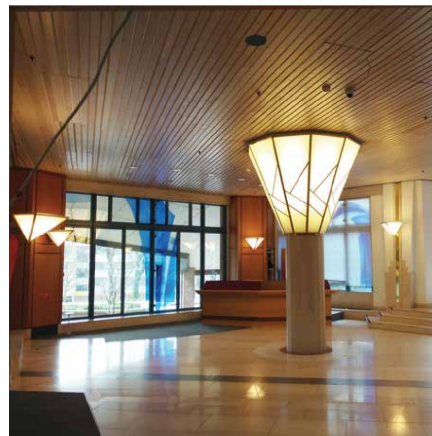
De monumentale verlichting blijft aanwezig, de PL-spots en tl-behuizing worden omgebouwd voor ledverlichting.
