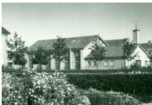
De gymzaal tijdens de bouw en na de oplevering in 1955
