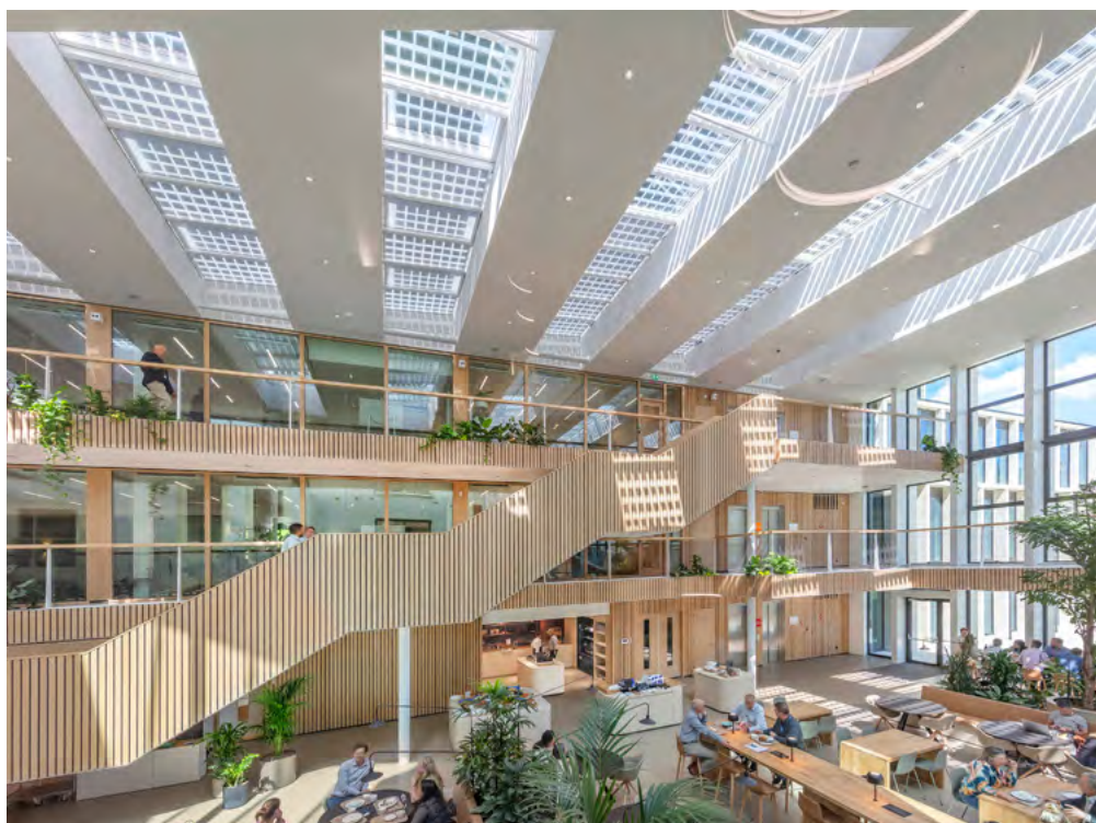
Foto 3: In het dak van het atrium zijn transparante zonnepanelen geplaatst.
